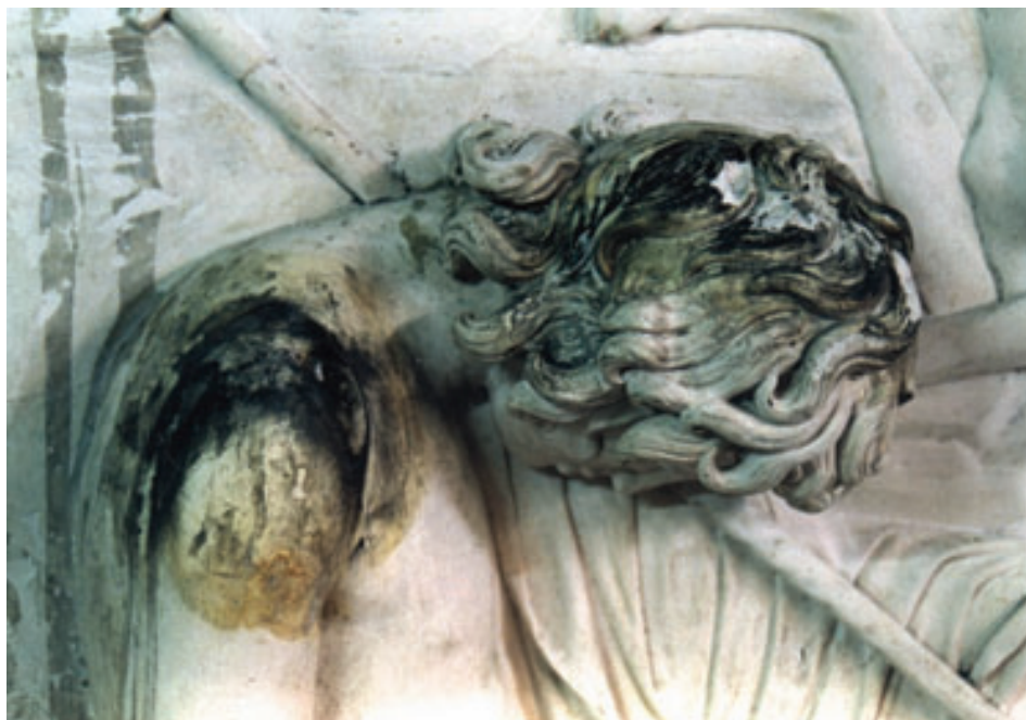
Detalle de deterioro por correntías de acqua porca. Real Academia de Bellas Artes de San Fernando, Madrid.
