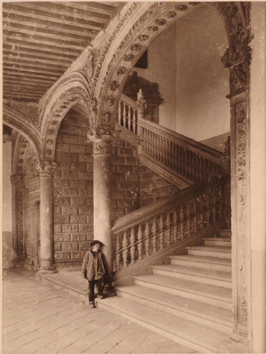
Alcalá de Plasencia. Escalera del Archivo.
