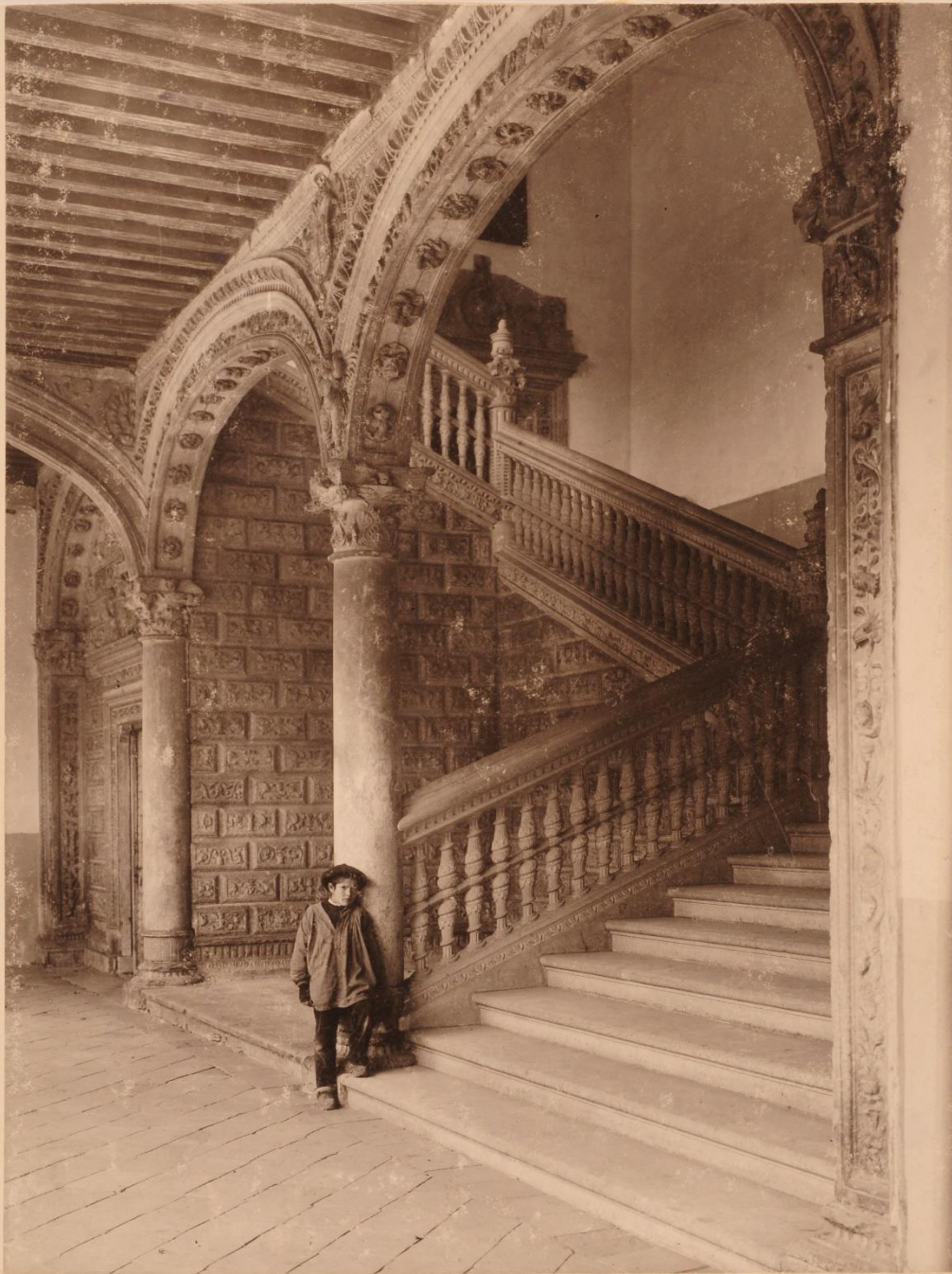
Alcalá de Segovia. Escalera del Archivo.
