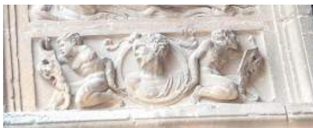
Dovela original realizada en piedra colocada en la línea de impostas izquierda. Sería la pieza que le faltaría a la Academia
