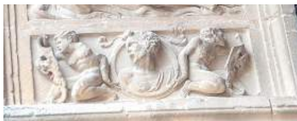
Dovela original realizada en piedra colocada en la línea de impostas izquierda. Sería la pieza que le faltaría a la Academia
