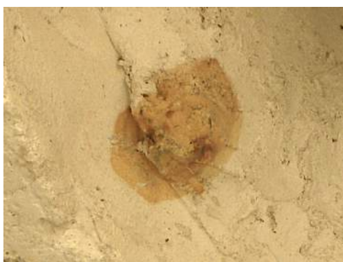
Tinción en el yeso debido a la oxidación de un refuerzo interno de hierro
