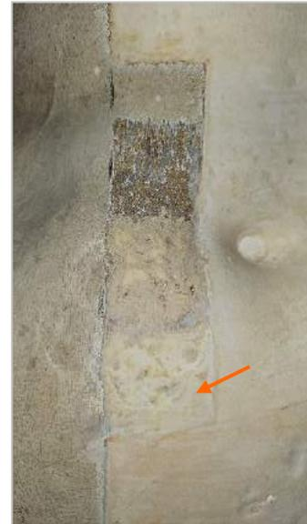
Figura 4.- Fotografía de detalle de la zona en la que se encuentra el punto del que se ha tomado la micromuestra "B" ensayada (indicado con una flecha de color anaranjado).
