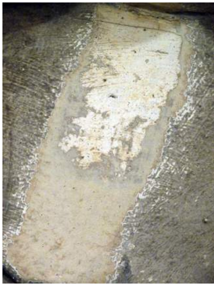
Primeras catas de eliminación de capas de pintura antes de comenzar la restauración
