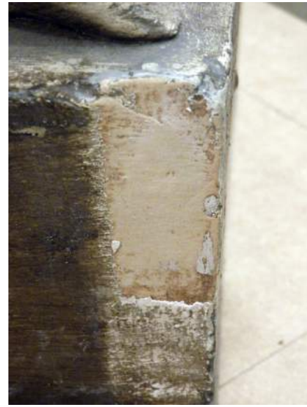
Primeras catas de eliminación de capas de pintura antes de comenzar la restauración
