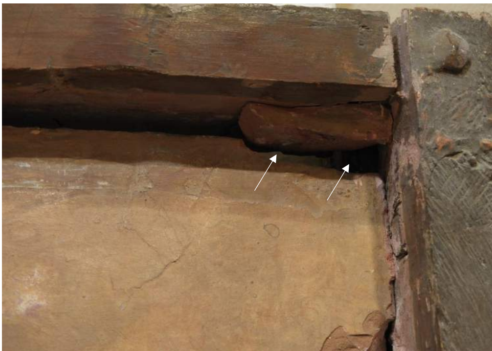
Relleno de yeso para unir el relieve al marco
