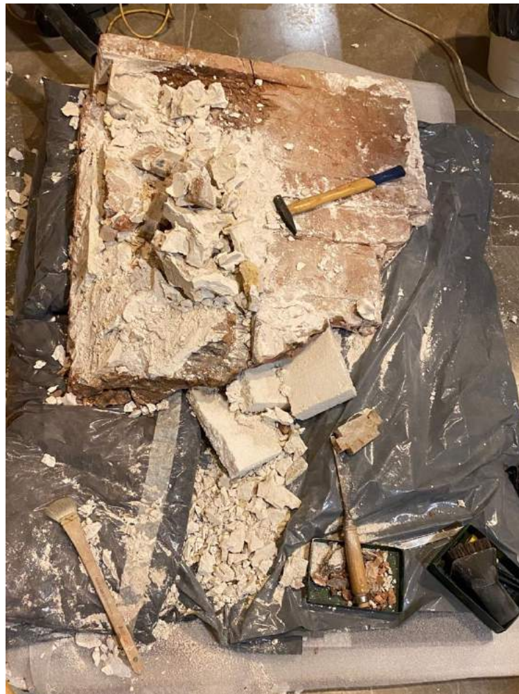
Proceso de eliminación del refuerzo de escayola para aligerar el peso de la pieza.
